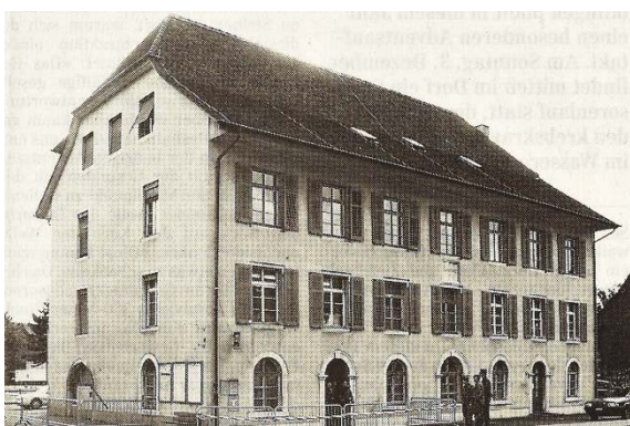
Bild 1: Hans Berger Kornhaus 1630 (später Schulhaus Unterdorf)
