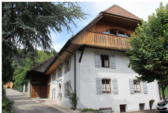
Wohnhaus mit Oekonomieeteil, 1804 Burgweg 2 24)
