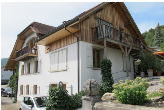
Wohnhaus mit Oekonomieeteil, 1850/1860 Burgweg 6 21)
