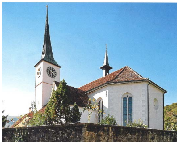
Pfarrkirche St. Georg, 1644/1648 Ausserbergstrasse 10
